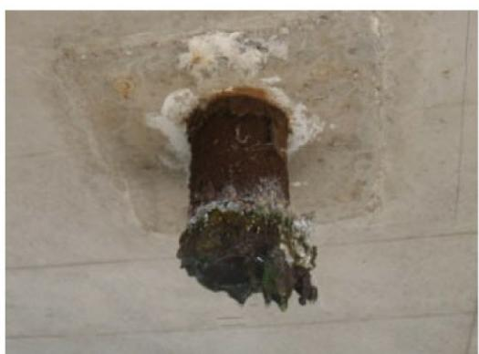
図 2.1 既設管腐食例
