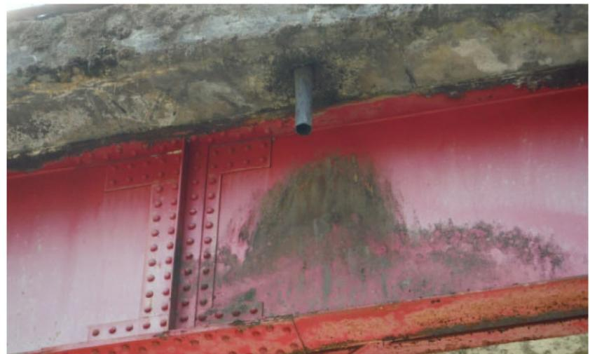
図 2.2 飛沫水による栓への影響例
