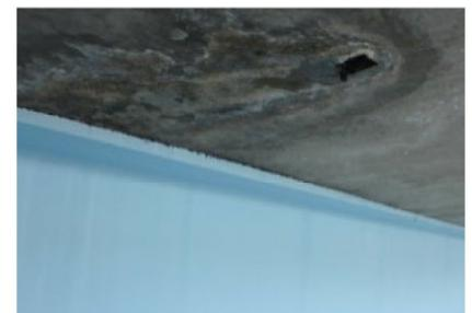
図 2.3 隙間や長さが足りず漏水している例
