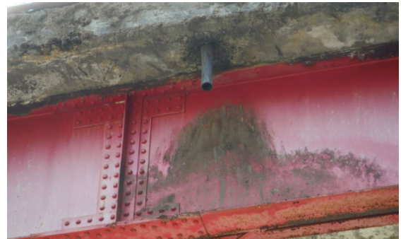
図 2.2 飛沫水による柵への影響例
