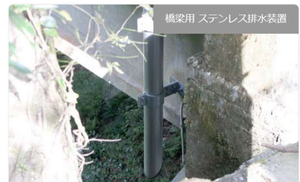
橋梁用 ステンレス排水装置
