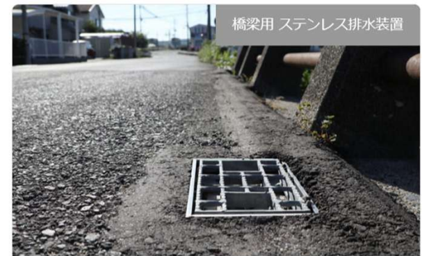
橋梁用 ステンレス排水装置
