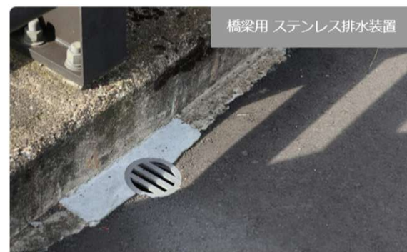
橋梁用 ステンレス排水装置
