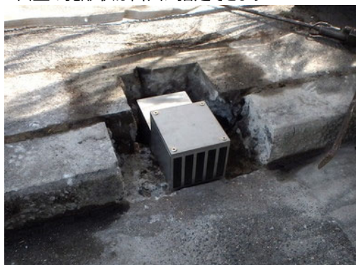
⑩設置例 二重目皿付き 設置工事中例
