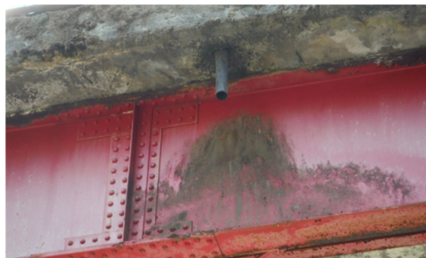
図 2.2 飛沫水による桁への影響例
