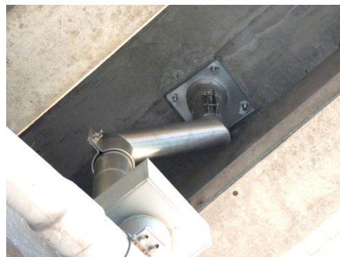
⑨設置例 接続までの導水に用いた例
