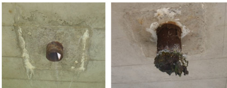
図 2.1 既設管腐食例
