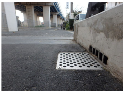
⑦設置例 L型（SUS目皿）例
