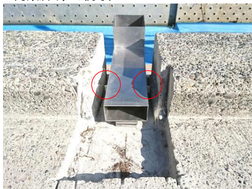
⑪設置工事中例 ストッパー付き
