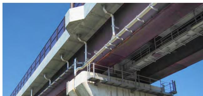
橋梁用排水装置「高気密ステンレス排水管」と「円筒型枠」
