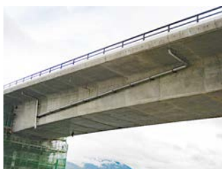
国土交通省 九州地方整備局 鹿児島港湾・空港整備事務所 鹿児島港(中央港区)橋梁(C)(P2-A2) 上部工事
