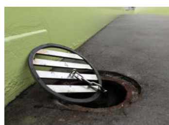
丸形状 目皿のみ例 (既設とチェーン接続)
