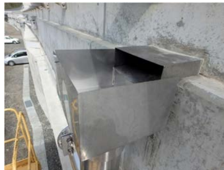
⑰設置例（地覆貫通～横引き管） 左記⑯の横引き管と受樹付き管を上から見た写真になります。
