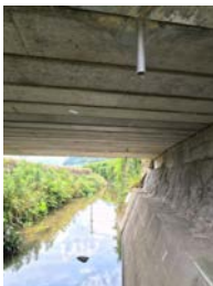
小径丸管の天端にプレート（アンカー、ボルト用孔有り）付き
