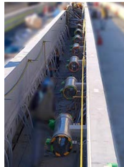
補修 他管種接続 設置例 ※伸縮管を使用しVP管接続
