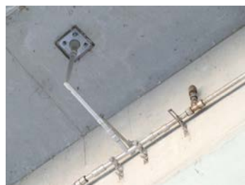
設置例⑧ 小径パイプ一体形状 ※旧仕様の4孔プレート
