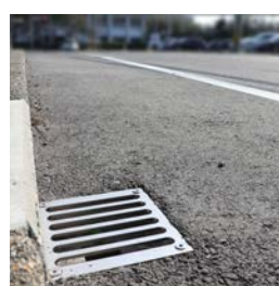
設置・形状例⑥ 柵枠にストッパー取付けられている例
