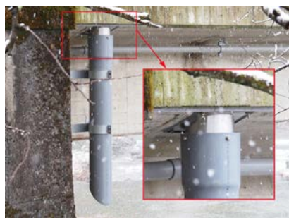
塩ビ管 ボルト接続例①
