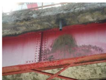
⑤ 排水管が短く、桁に飛沫水があたっている。
