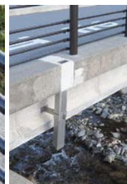
T桁（地覆斫り）※鉛直管天端は掃除蓋無し
