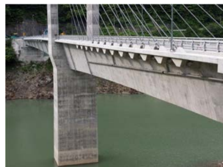
ダム湖への施工例 岐阜県揖斐郡
