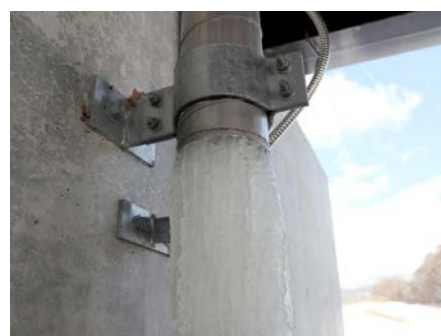
⑨積雪および降雪 -2 スパイラル直管の流末部です。氷柱（つらら）が見えています。
