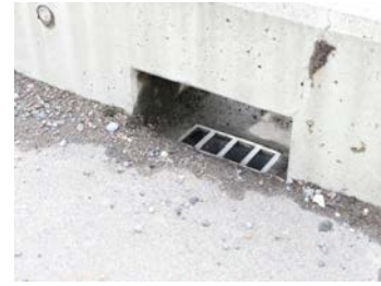
角管仕様 プレート付き（アンカー用孔無し）例
