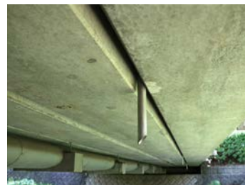
地覆立ち上がりから間詰部まで排水のため、横断方向が長く目皿2枚仕様としています。
