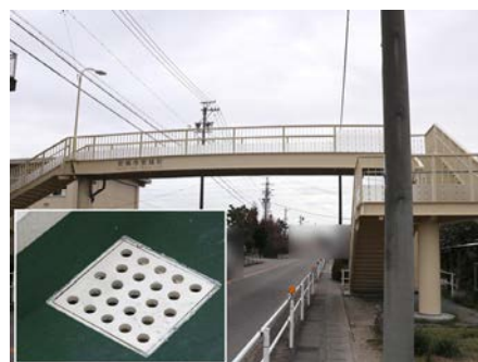
⑪塗装例 -5 排水柵目皿に白色系統の塗装が施されています。
