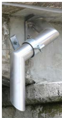
L形状曲プレート+曲げ管の組み合わせ例
