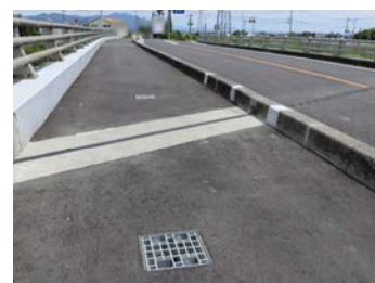
下記図の鉛直管を設置
