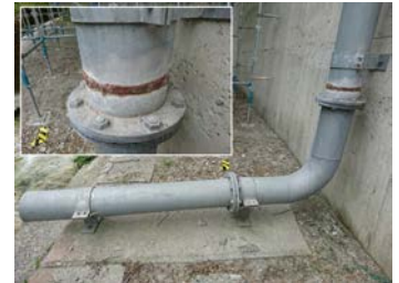
その他不具合例 長さ調節のため、カットし溶接した箇所から腐食が進行している。
