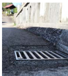
舗装天端からの平面目皿で導水部地覆内埋設例
