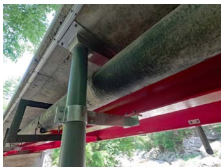
⑧ 設置例（角受枠形状+塩ビ管接続） 添架管を避けるため、薄型の受枠形状で製作 設置し塩ビ管に設置しています
