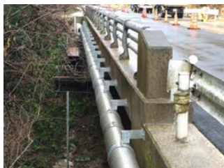
島根県 松江県土整備事務所 国道432祖父谷千成橋橋梁添架
