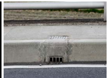
丸パイプ接続（左右2箇所）、目皿（2箇所）仕様 ※歩道部に使用 歩道部等、似た形状の事例は → P.77もあわせてご覧ください。
