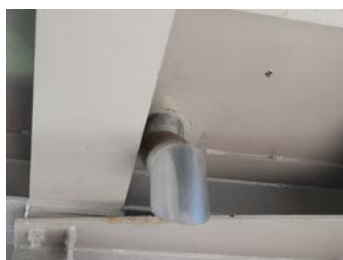
曲管に目皿、全周支持プレートを溶接一体とした例
