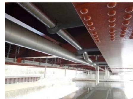
⑥新設橋 鋼橋
