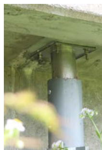
塩ビ管 ボルト接続例②
