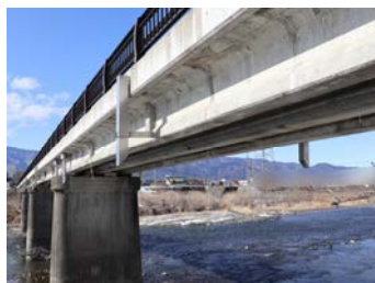
T桁（地覆打替）
