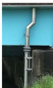
伸縮管 接続例② (高気密ステンレス管接続)
