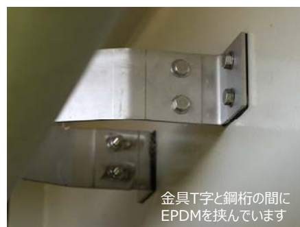
鋼桁にステンレス製支持金具を使用例②
