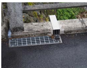
飲み口がL型形状で平面部グレーチング仕様
