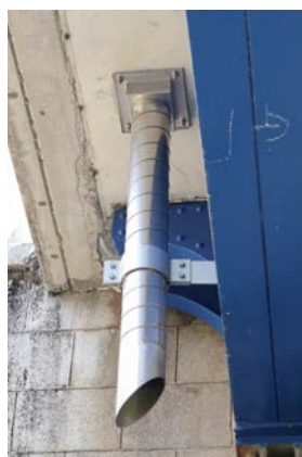
パイプ部分がスパイラル直管の例
