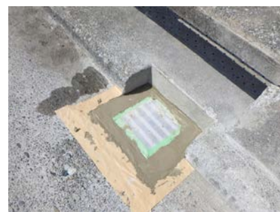
⑨排水桡設置完了
