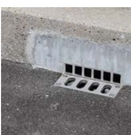
設置・形状例⑤ 地覆内に収めたL形状
