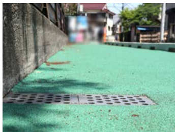
地覆立ち上がりから間詰部まで排水のため、横断方向が長く目皿2枚仕様としています。
