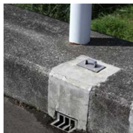
RC床版（地覆斫り）
