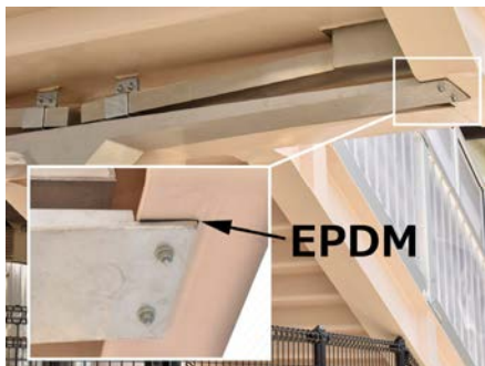
横断歩道橋にステンレス樋設置例 → P.56
