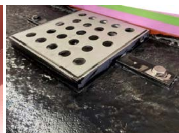
(補修) 鋼床版へボルト接続にて設置例 ※下面に絶縁用EPDM、絶縁 (FRP) ワッシャー有り
