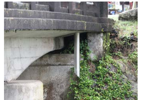
床版貫通管例 補修で使用 → P.59
