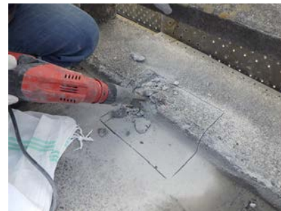
③床版、地覆斫り
