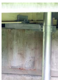
鋼桁下フランジへ取付け例②
