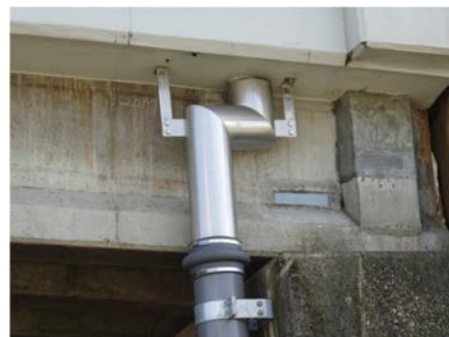
⑥設置例（金具取付け用PL一体）
