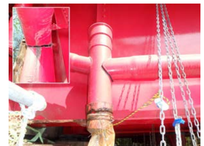
③ 経年による劣化、排水管と主桁の熱伸縮差により、裂けが発生している。特に塩ビ管では熱膨張率の違いが大きく注意が必要となる。→ P.124
