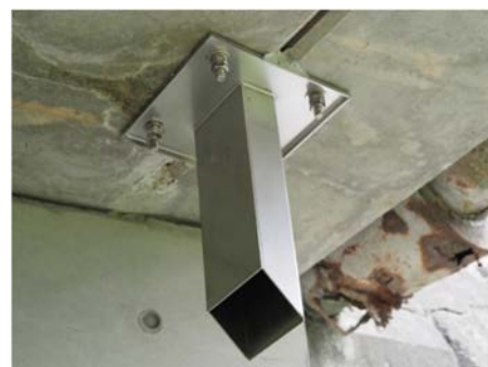
⑥ 設置例 角管仕様 角型管の製作例です 曲管の製作も可能です
