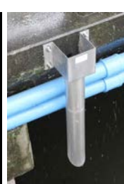
受樋形状に取付けプレート＋排水管 地覆の角度に合わせ受樋下に斜プレート が付いています
