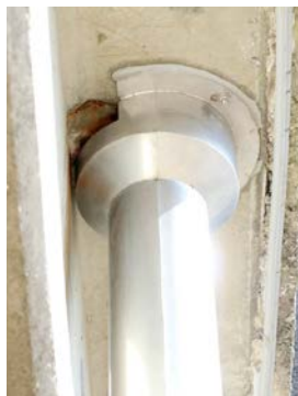
斜めにできてきている既設柵の流末を避けるための形状例②
