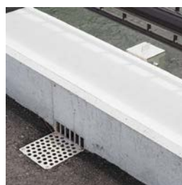
地覆打ち替え時事例
