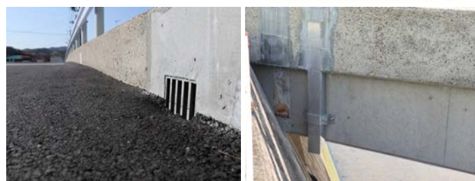
地覆の外側面に合わせての設置例
