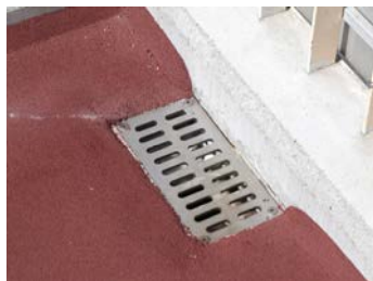
(補修) デッキプレートへ設置例 ※下面に絶縁用EPDM有り
