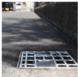
ボルト箇所にもゴムカバー有り
