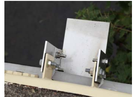
桁付ビースにステンレス金具設置例 → P.69
