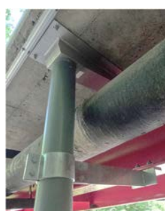
鋼桁下フランジへ取付け例
