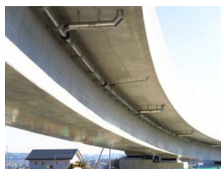
群馬県 渋川土木事務所 道路改築(仮称)金井陸橋上部工事
