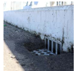
アンカー固定プレート付き形状
