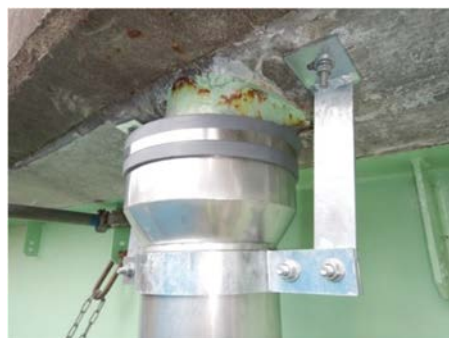
⑪設置例（RDジョイント使用）
