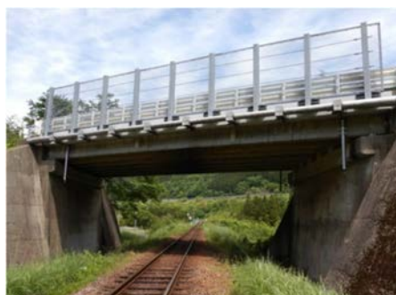
跨線橋への施工例 岐阜県郡上市
