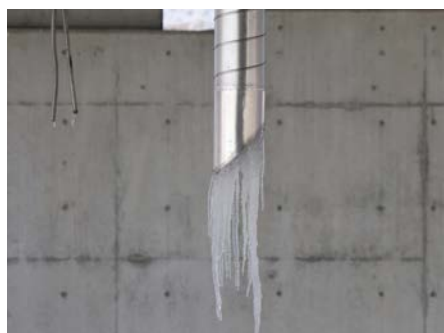
⑩積雪および降雪 -3 スパイラル直管 + 斜切の流末部です。氷柱（つらら）が見えています。
