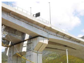
国土交通省 中部地方整備局 紀勢国道事務所 新里川橋梁PC上部工事
