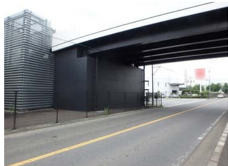
①新設橋 鋼橋
