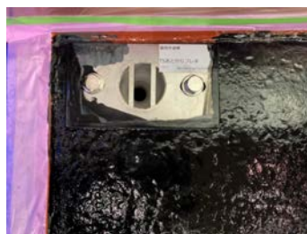
施工時写真 (防水層塗布時点)
