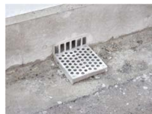
舗装工事前（地覆打設後）
