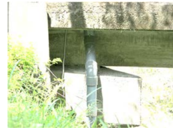
他管種 (VP管) 接続例
