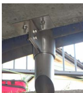
桁下面へ取付け例
