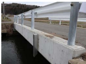
木ロー桁（地覆打替）
