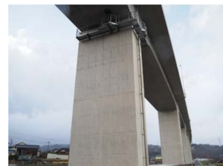
⑫新設橋 PC橋
