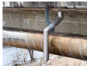
添架管避け曲げ (外へ) 吊下金具
