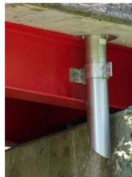
斜めにできてきている既設柵の流末と上フランジを避けるための形状例
