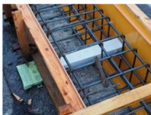
横引き部の地覆打設前
