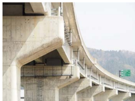
④新設橋 PC橋
