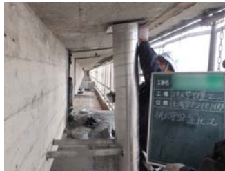
排水管取付け
