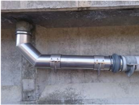
⑬設置例（RDジョイント+伸縮管） 樹との接続はRDジョイント、他管種との接続は伸縮管を使用しています。 図例 P.114-①③
