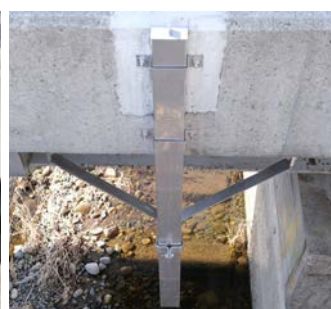
地覆下面へ二股金具の取付け例
