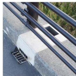
T桁（地覆斫り）※鉛直管天端は掃除蓋無し
