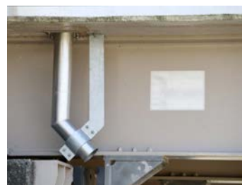
橋台・落橋防止装置を避けた例③
