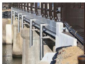
鋼製地覆への使用例（新設）※EPDMを挟み絶縁 絶縁について → P.132
