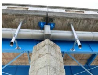
愛媛県 西条市 室川橋補修工事
