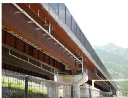
⑧新設橋 鋼橋
