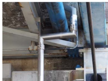
⑫設置例（吊下げ金具使用）
