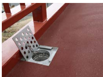
(補修) 鋼床版へボルト接続にて設置例 ※下面に絶縁用EPDM、絶縁 (FRP) ワッシャー有り
