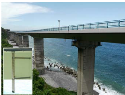
②海上および隣接箇所へ -2 上部工垂れ流しスパイラル管を使用しています。
