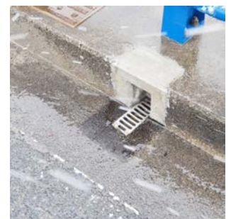
地覆内に食い込む形で製作設置例
