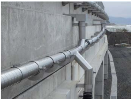
⑯設置例（地覆貫通～横引き管） 地覆貫通の横引きと添架排水管横引きの組み合わせになります。
