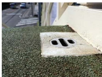
小径の製作、設置例。全周支持プレートはコンクリート内設置のため絶縁は不要です（鋼床版とパイプは接触しないよう設置）
