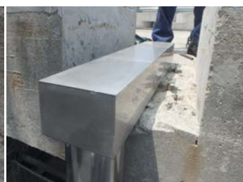
設置工事中写真② アンカーにて固定
