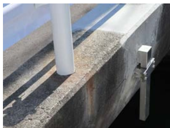
木ロー桁（地覆斫り）②
