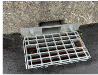
角パイプ接続、グレーチング仕様 地覆へアンカー打ち込み固定
