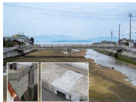
⑥海上および隣接箇所へ -6 地覆横引き（貫通）管を使用しています。
