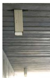
補修工事への設置例 水抜き孔が同方向へ2つ有り
