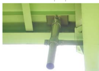
床版下面より ※排水管接続
