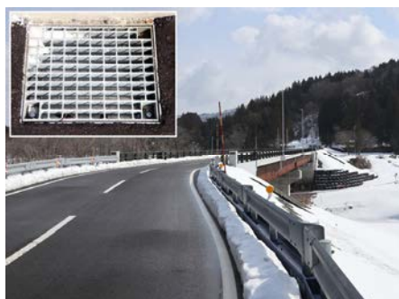
④積雪および降雪 -4 グレーチング仕様の排水柵を使用しています。
