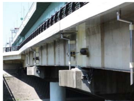
⑨設置例（既設金具流用）
