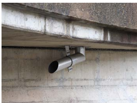
④ 設置例（下面） 排水を真下に落とさないようにしています
