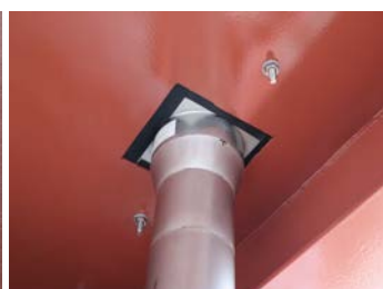
(補修) 鋼床版へボルト接続にて設置例 ※下面に絶縁用EPDM、絶縁 (FRP) ワッシャー有り
