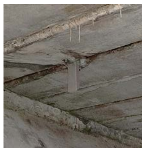
間詰部隙間へ挿し込むような形状の角管例。
