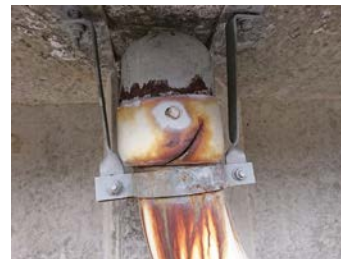
① 桁の流末箇所が腐食により膨らみ、塩ビ管が割れている。
