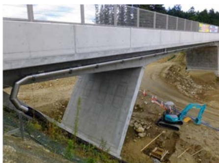
跨道橋への施工例 長野県上伊那郡
