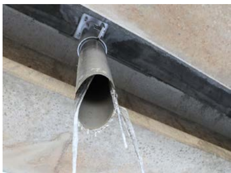
⑦ 設置例 寒冷地にて冬季で氷柱（つらら）ができています
