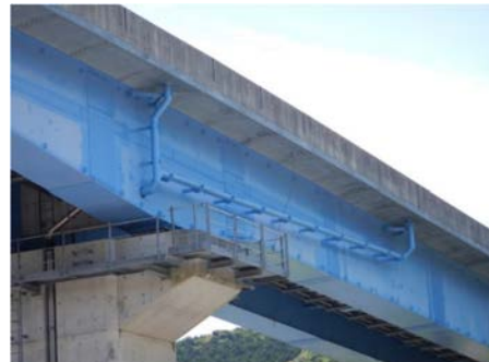
③新設橋 鋼橋
