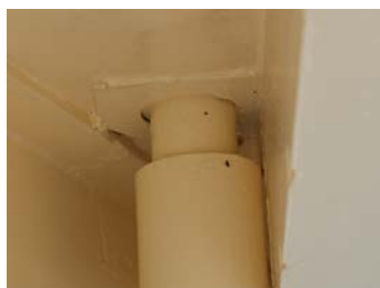
小径の製作、設置例。全周支持プレートはコンクリート内設置のため絶縁は不要です（鋼床版とパイプは接触しないよう設置）
