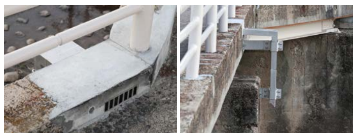
地覆目皿横方向、横引き部が長い例
