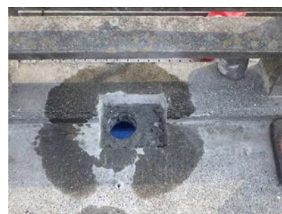
⑥コア抜き完了
