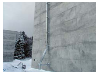
北海道開発局 函館開発建設部 函館江差自動車道 新幸連川橋下部工事
