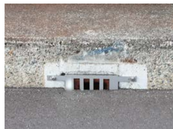
設置例①（EPDM挟み設置）
