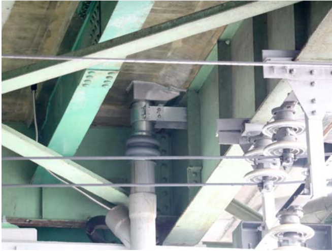
床版下面にアンカー設置では無く、支持金具で押し上げるような形で設置
