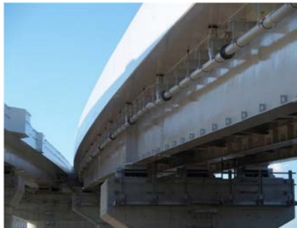
②新設橋 鋼橋
