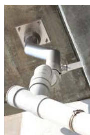
塩ビ管へ挿し込み例②
