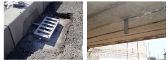
設置後 床版上
