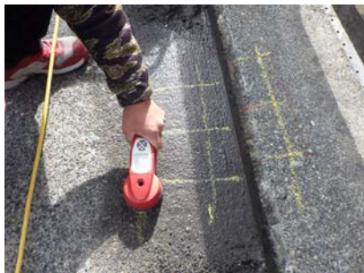
①鉄筋探査
