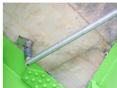
⑫ 設置例（小径管） ステンレス小径管を天板プレート形状で製作、設置例になります
