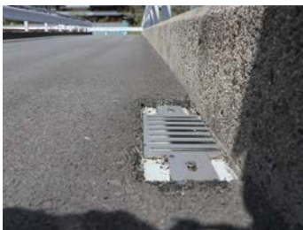
アンカープレートが天端と同じ高さ例（めねじアンカー、極低頭ボルト取付け）
