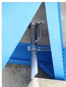
フレキシブルチューブ挿し込み
