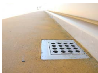
ゴムチップ舗装天端に合わせ全周支持プレート付きの製作・設置例
