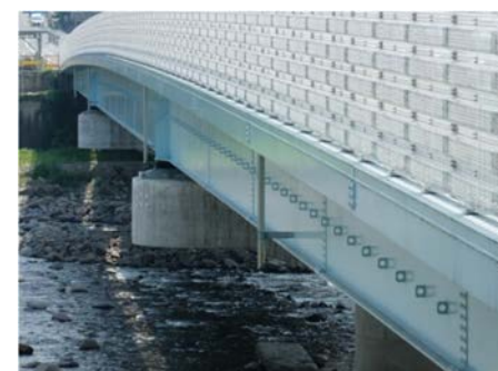
⑨新設橋 鋼橋
