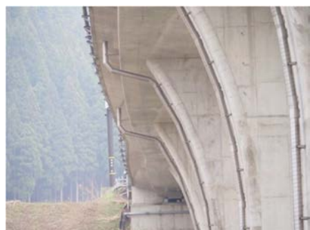
⑩新設橋 PC橋
