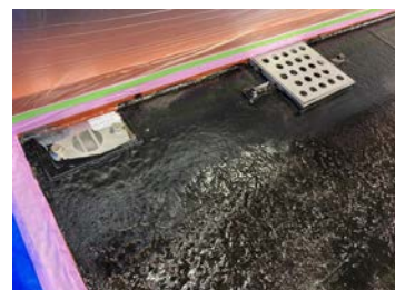
施工時写真 (防水層塗布時点)
