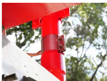
使用例⑤ 排水管に塗装有り
