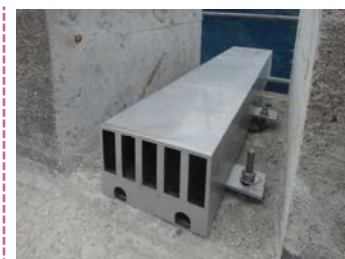
設置工事中写真② アンカーにて固定
