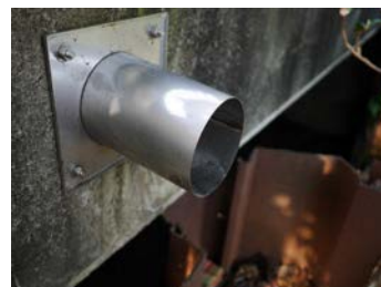
水切りとして使用した例（丸管仕様）
