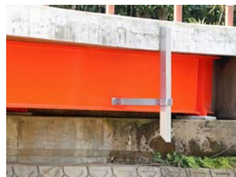
鋼桁（地覆斫り）①
