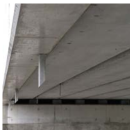
木ロー桁（新設）①
