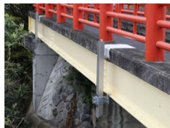
鋼桁（地覆斫り）②
