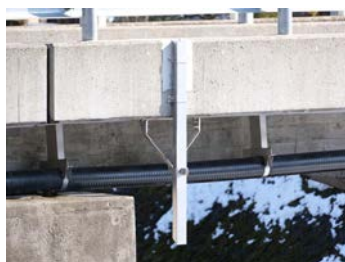
二股吊下げ金具使用例
