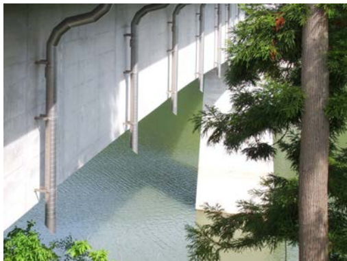
スパイラル直管+斜切管を使用した垂れ流し管の例
