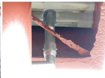
(補修) デッキプレートへ設置例 ※下面に絶縁用EPDM有り
