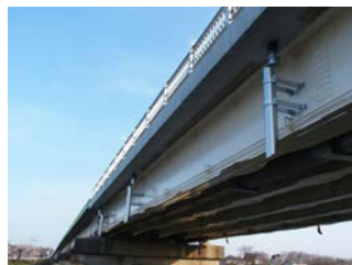
宮城県 大河原土木事務所 大河原大橋耐震補強・拡幅工事
