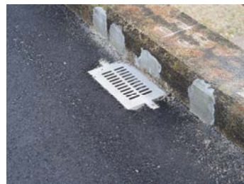
アンカープレートが天端と同じ高さで枠あり例（めねじアンカー、極低頭ボルト取付け）
