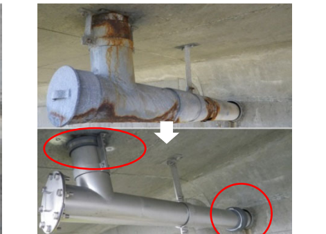
⑱設置例（RDジョイント・伸縮管使用） 排水樹との接続にRDジョイント、SGP管との接続に伸縮管を使用し絶縁をしています。 図例 P.114-③
