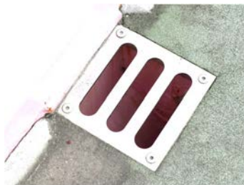
底面無し、桟+目皿例 (目皿ボルト固定)
