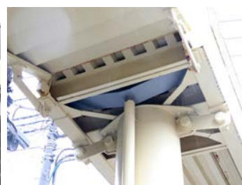
設置条件に合わせ端部が異形の例
