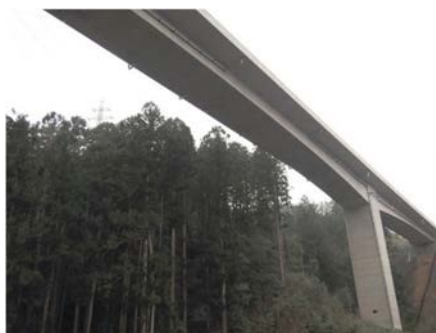
⑪新設橋 PC橋
