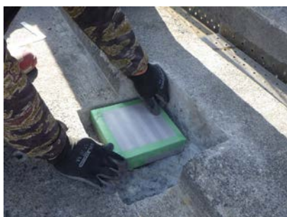
⑦排水桟設置
