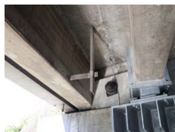
T桁下面より
