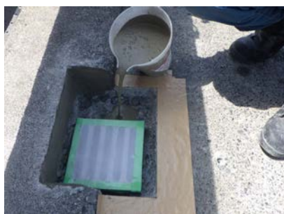
⑧無収縮モルタル打設
