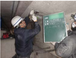
アンカー削孔
