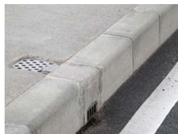
丸パイプが横向きに付いており埋設された管に接続されています
