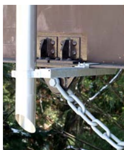
鋼桁下フランジへ取付け例①
