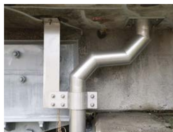
橋台・落橋防止装置を避けた例①
