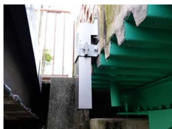
角管をデッキプレートの側面へ設置
