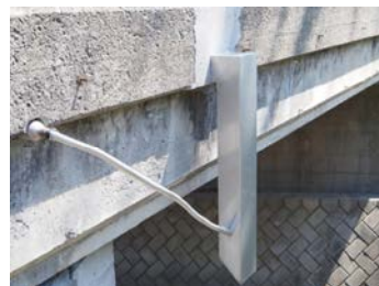
フレキシブルチューブ接続例
