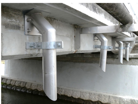
⑪ 設置例（L形状プレート） L型形状プレートの設置例になります
