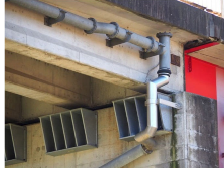
⑭設置例（伸縮管+フランジ接続例） 他管種との接続に伸縮管とフランジを用いた例になります。 図例 P.113-⑦
