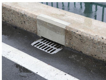
間詰部と歩車道境界ブロックが平行でないため、柵枠に対し斜めに角管を取付けています。
