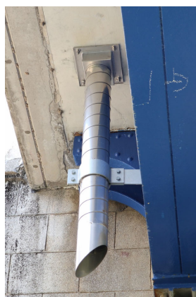
パイプ部分がスパイラル直管の例
