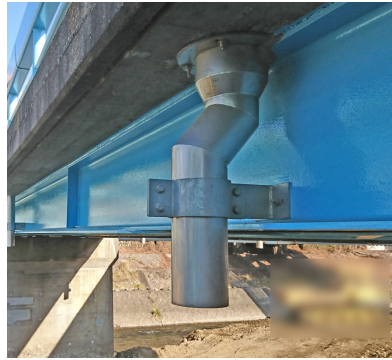
鋼桁の上フランジとの接触を避けるための形状例
