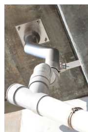
塩ビ管へ挿し込み例②
