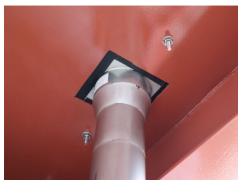
(補修) 鋼床版へボルト接続にて設置例 ※下面に絶縁用EPDM、絶縁 (FRP) ワッシャ有り
