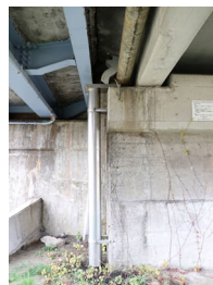
受桝が排水管一体となり、排水管側（下部へ取付け）で固定
