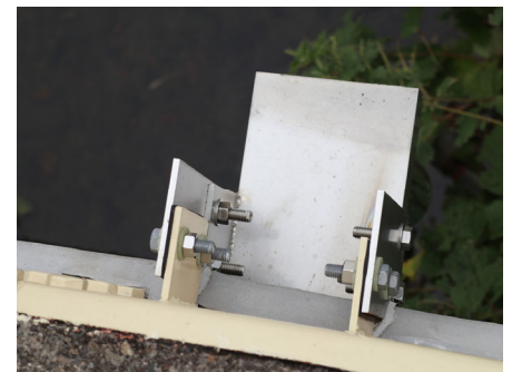
桁付ビースにステンレス金具設置例 → P.69
