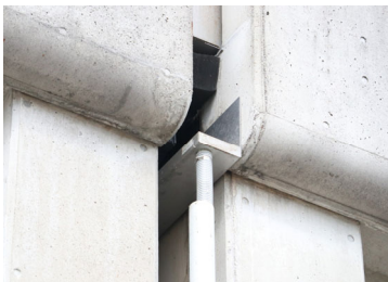
補強プレートを溶接し薄型で一本物で製作例
