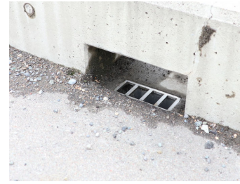
角管仕様 プレート付き（アンカー用孔無し）例
