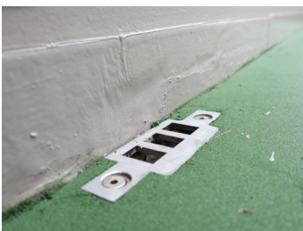
目皿のみ例 (めねじアンカーにてボルト固定)
