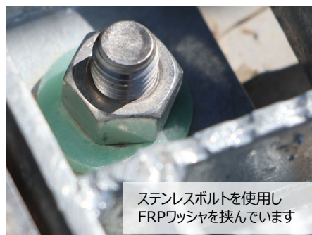
ステンレス排水桝に鋼製（めっき）グレーチング例
