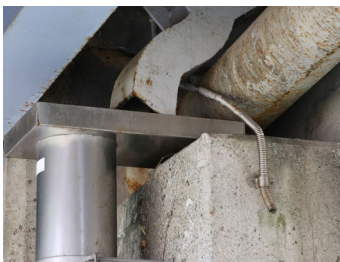
受桝が排水管一体となり、排水管側（下部へ取付け）で固定
