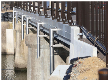
② 鋼製地覆へ横向き設置例 絶縁のため、P.102/P.134記載のEPDMを挟んでいます
