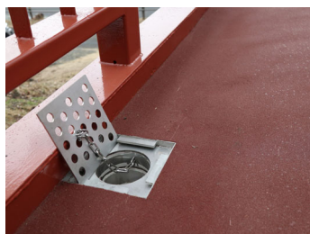
(補修) 鋼床版へボルト接続にて設置例 ※下面に絶縁用EPDM、絶縁 (FRP) ワッシャ有り
