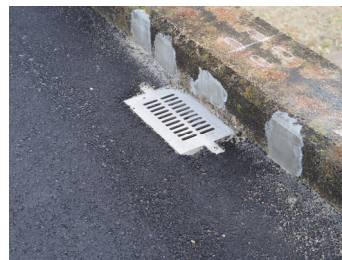
アンカープレートが天端と同じ高さで枠あり例（めねじアンカー、極低頭ボルト取付け）
