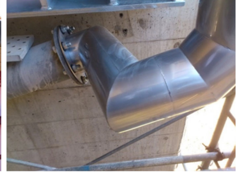
⑮設置例（フランジ接続） 左記⑭のフランジ接続箇所の拡大写真です。 図例 P.113-⑦
