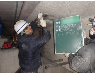
アンカー削孔
