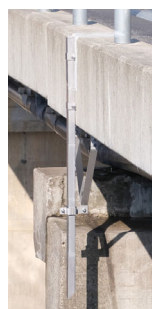
鋼桁下フランジへ取付け例②
