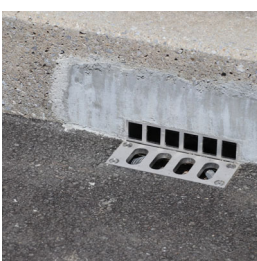
設置・形状例⑤ 地覆内に収めたL形状
