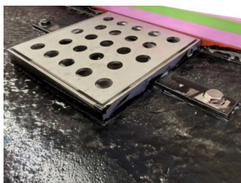
(補修) 鋼床版へボルト接続にて設置例 ※下面に絶縁用EPDM、絶縁 (FRP) ワッシャ有り
