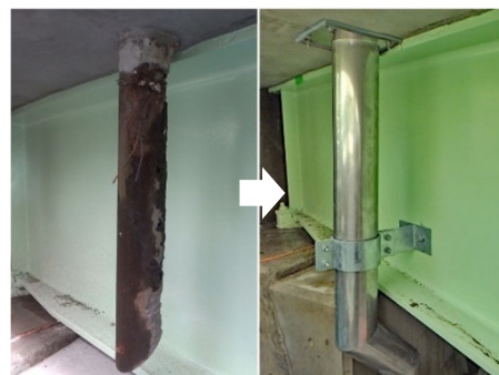
⑨ 設置例 工事前と工事後の写真になります。工事後は下部へ導水するため、曲管としています
