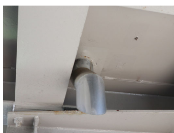
曲管に目皿、全周支持プレートを溶接一体とした例
