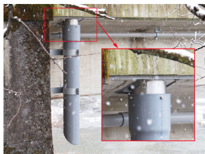
塩ビ管 ボルト接続例①
