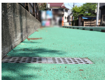
地覆立ち上がりから間詰部まで排水のため、横断方向が長く目皿2枚仕様としています。
