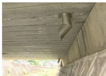
天板プレート 丸管クランク有り
