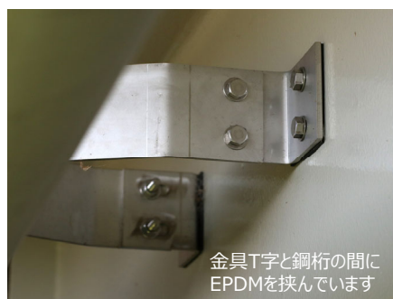
鋼桁にステンレス製支持金具を使用例②
