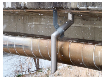
添架管避け曲げ（外へ）吊下金具
