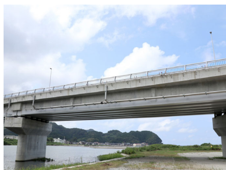
⑦海上および隣接箇所へ -7 TS-PIPE φ200を使用しています。
