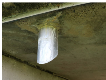
排水桧とコンクリート間より漏水している例
