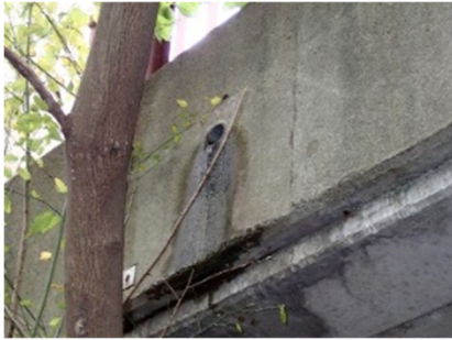
横引き排水の水切りとして使用した例
