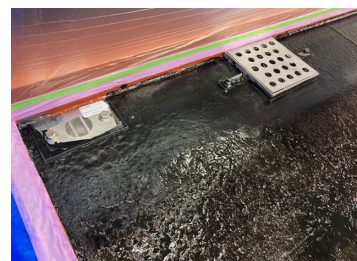
施工時写真 (防水層塗布時点)
