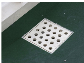
(補修) デッキプレートへ設置例 白系の塗装が施されています ※下面に絶縁用EPDM有り (接続排水管は樹脂系)
