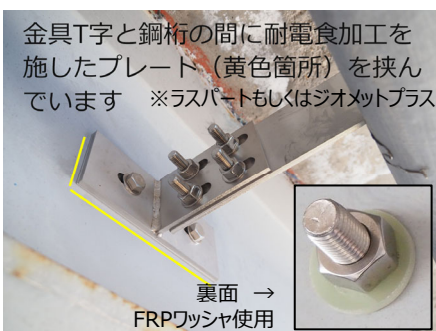
鋼桁にステンレス製支持金具を使用例①
