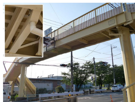
⑫塗装例 -6 樋にグレーベージュ系統の塗装が施されています。
