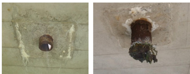
図 2.1 既設管腐食例
