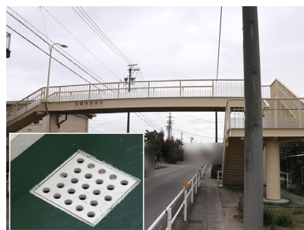
⑪塗装例 -5 排水樹目皿に白色系統の塗装が施されています。
