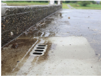
床版上位置にプレート（管全周）有り例
