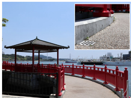
④海上および隣接箇所へ -4 海上遊歩道へ小型の排水柵を使用しています。
