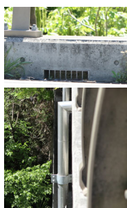
横引き管、鉛直管が丸パイプ形状
