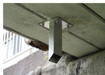
スラブ・ホロー 桁下間詰部の例 事例は → P.42を 参照ください
