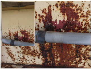
床版排水材からの導水が無く、桁に飛沫水があたっている。
