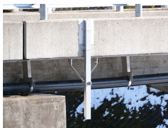
二股吊下げ金具使用例
