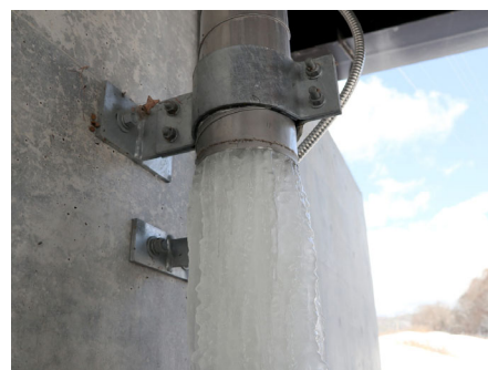
⑨積雪および降雪 -2 スパイラル直管の流末部です。氷柱（つらら）が見えています。
