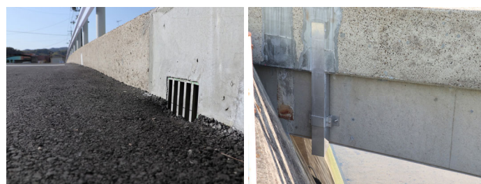
地覆の外側面に合わせての設置例
