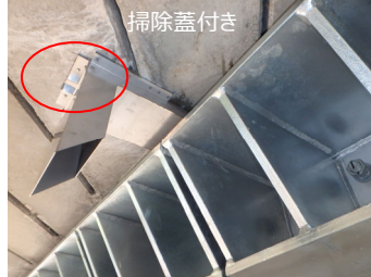
鋼製ブラケット取付け前に水切り用の プレートを設置
