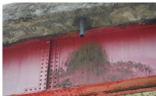
図 2.2 飛沫水による桁への影響例
