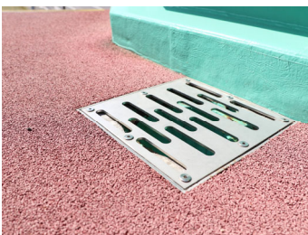
底面無し、高さの低い桝+目皿例 (目皿ボルト固定)
