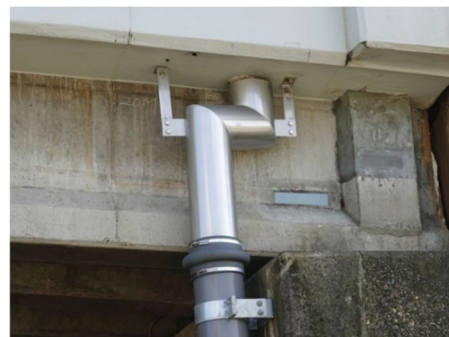
⑥設置例（金具取付け用PL一体）
