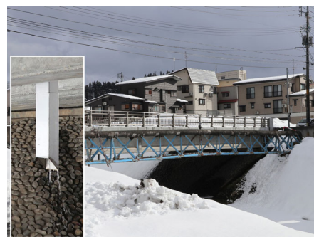
⑫積雪および降雪 -5 角管の流末部です。氷柱（つらら）が見えています。
