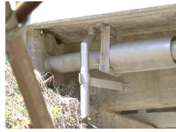
排水管との組み合わせ例 (ボルト取付け)
