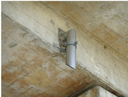
横引き排水を桁下までの導水に用いた例
