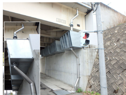
⑥落橋防止装置 貫通例 落橋防止装置を排水管が貫通している例になります。
