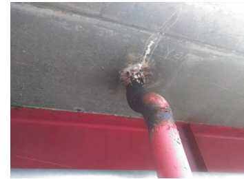
② 枅とコンクリートの隙間から遊離石灰や浸水、滞水が発生している。
