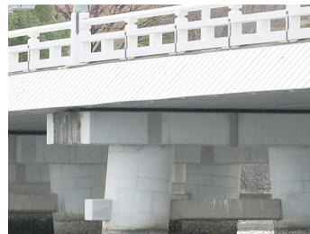
アンカープレート一体の薄型樋
