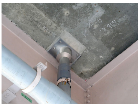
⑩ 設置例 塩ビ管に接続しています
