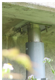
塩ビ管 ボルト接続例②
