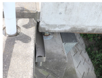
遊間端部下への設置・製作例
