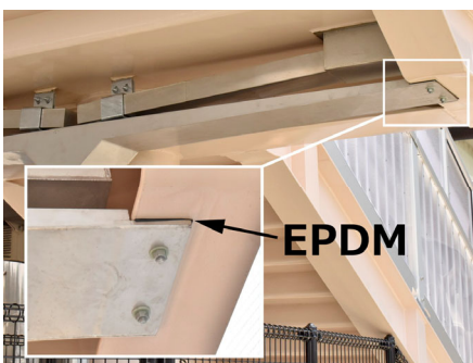
横断歩道橋にステンレス樋設置例 → P.56
