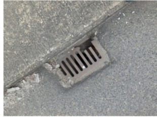
⑥ 蓋が損傷、破損している。
