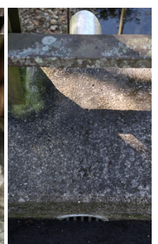
地覆外部分が斜めの形状例
