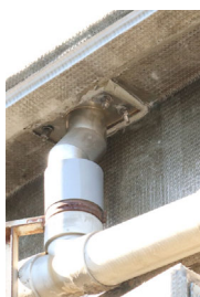
塩ビ管へ挿し込み例①
