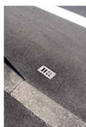
補修工事への設置例 水抜き孔が同方向へ2つ有り
