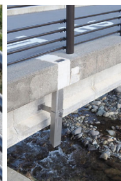
T桁（地覆斫り）※鉛直管天端は掃除蓋無し
