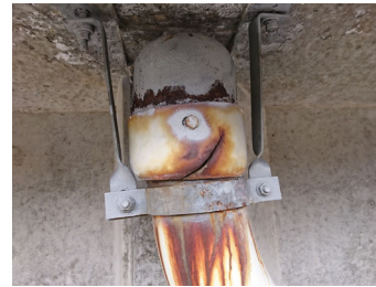
① 枅の流末箇所が腐食により膨らみ、塩ビ管が割れている。
