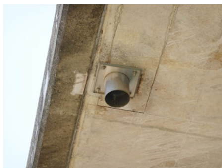
⑤ 設置例（極短め） 既設埋設管の流末が腐食のため、水切りとして設置した短い管の例です
