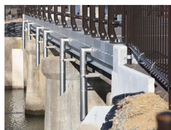
鋼製地覆への使用例（新設）※EPDMを挟み絶縁 絶縁について → P.132
