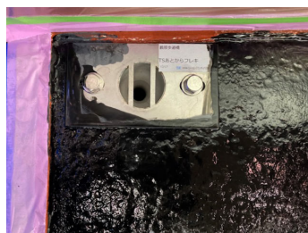
施工時写真 (防水層塗布時点)
