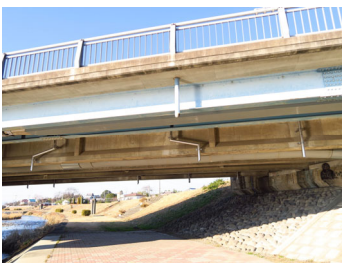
排水管との組み合わせ例 (挿し込み+TSカップリング)
