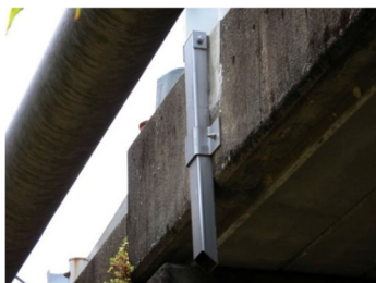
ボルト一本で鉛直管を貫通し 掃除蓋を取付けた例
