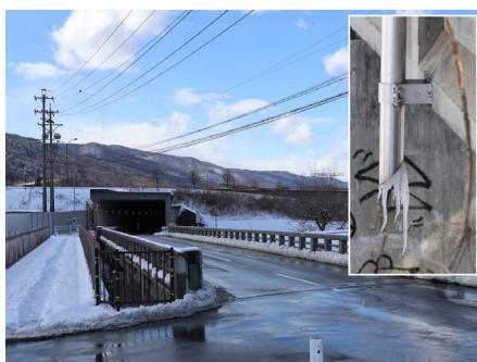
⑪積雪および降雪 -4 加工管の流末部です。氷柱（つらら）が見えています。
