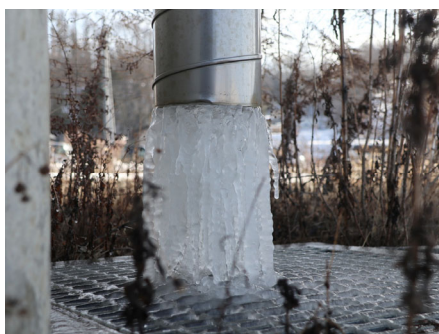
⑧積雪および降雪 -1 スパイラル直管の流末部です。氷柱（つらら）が見えています。
