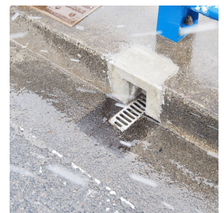
地覆内に食い込む形で製作設置例
