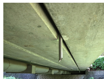
地覆立ち上がりから間詰部まで排水のため、横断方向が長く目皿2枚仕様としています。
