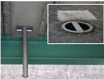
CTスラブへ設置写真例 (下面よりアンカー設置)
