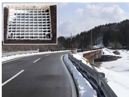
④積雪および降雪 -4 グレーチング仕様の排水樹を使用しています。
