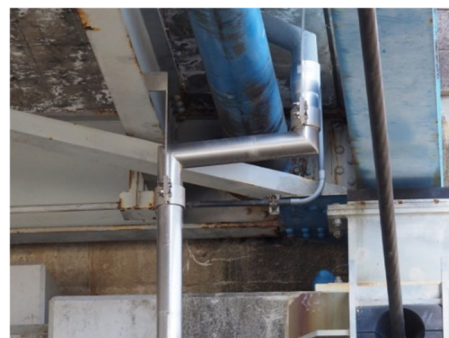
⑫設置例（吊下げ金具使用）
