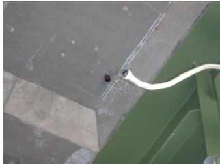
その他不具合例 床版排水材に接続したフレキシブルチューブが外れている。
