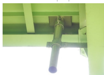
床版下面より ※排水管接続
