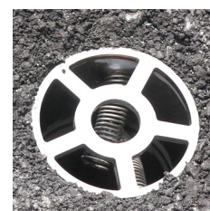
導水管がパイプ内を覆っている
