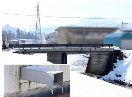
①積雪および降雪 -1 角型の地覆横引き（貫通）管です。
