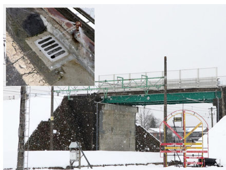
⑤積雪および降雪 -5 SUS目皿仕様の排水樹を使用しています。 消雪施設より散水しています。
