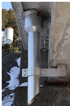
斜めにできてきている既設柵の流末を避けるための形状例①
