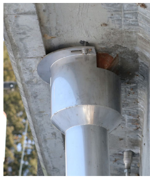
斜めにできてきている既設柵の流末を避けるための形状例①
