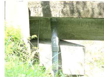
他管種 (VP管) 接続例
