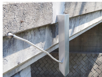
フレキシブルチューブ接続例
