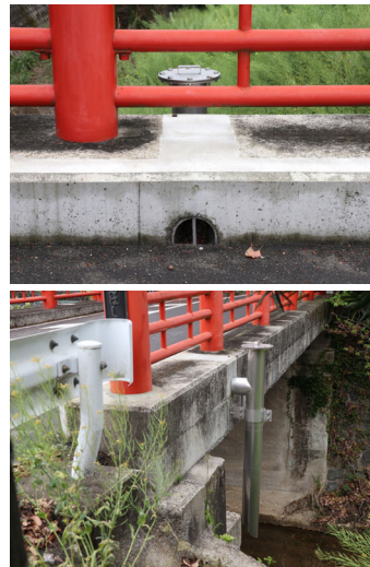
ボルト締めによる掃除蓋付き例
