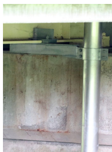
鋼桁下フランジへ取付け例②
