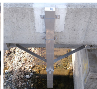
地覆下面へ二股金具の取付け例
