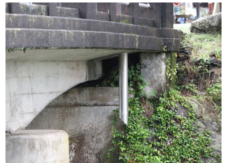
床版貫通管例 補修で使用 → P.59
