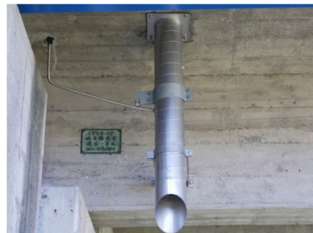
③ 設置例 スパイラル直管仕様 スパイラル直管を使用した例です。写真ではフレキシブルチューブを接続しています
