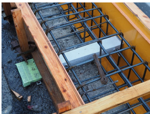
②⑨施工途中 ②⑧の横引部の地覆打設前
