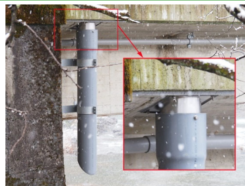
⑮設置例（VP管へ接続例）
