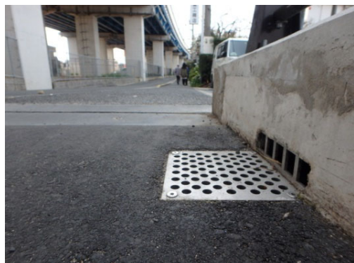
⑦設置例 L型（SUS目皿）例
