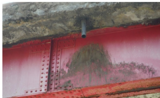
図 2.2 飛沫水による桁への影響例
