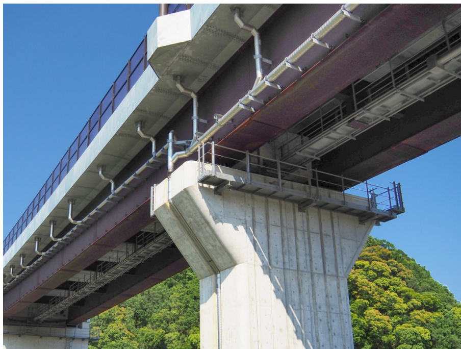
橋梁用排水装置「高気密ステンレス排水管」と「円筒型枠」
