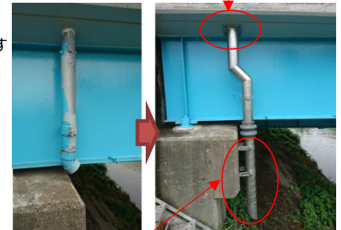
スパイラル直管＋斜切管仕様／専用SUS金具
