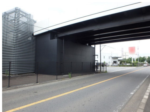
②⑤新設橋 鋼橋 黒色系統の塗装を施しています
