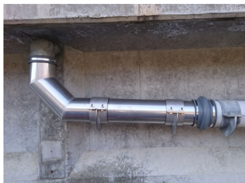
⑬設置例（RDジョイント+伸縮管）
