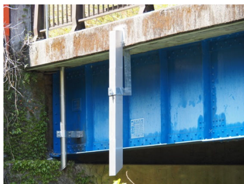
⑲設置例 横角管仕様（吊り下げ金具使用）
