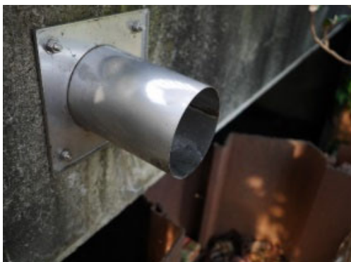
・横引排水の水切りとして使用した例
