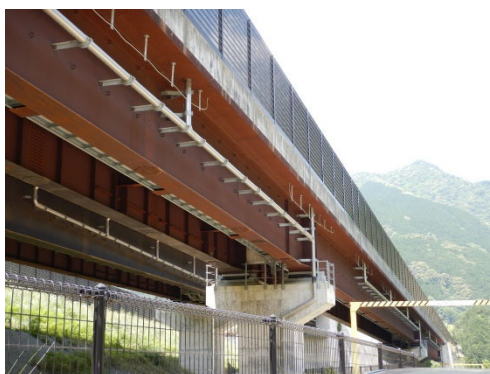
③⑫新設橋 鋼橋 TS-PIPE φ200を使用しています
