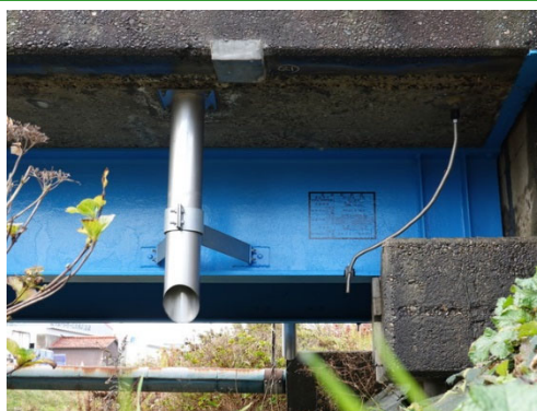
⑭設置例（鋼桁へ二股金具使用）
