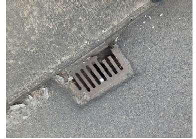
目皿部（鋼製）損傷例
