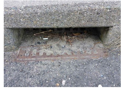
目皿部（鋼製）損傷例
