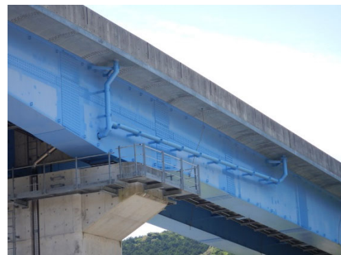
②⑦新設橋 鋼橋 青色系統の塗装を施しています
