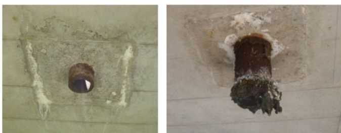
図 2.1 既設管腐食例
