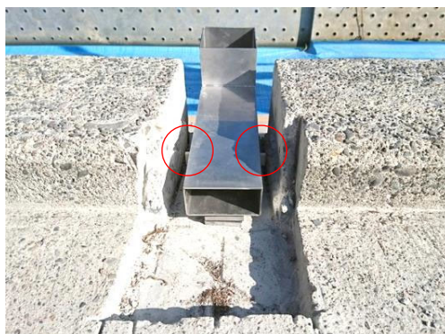
⑪設置工事中例 ストッパー付き
