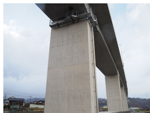
③⑯新設橋 PC橋 TS-PIPE φ200を使用しています
