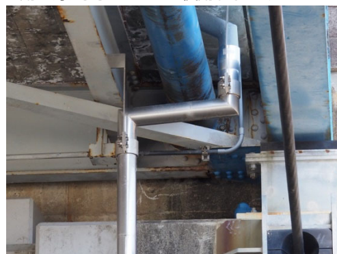
⑫設置例（吊下げ金具使用）
