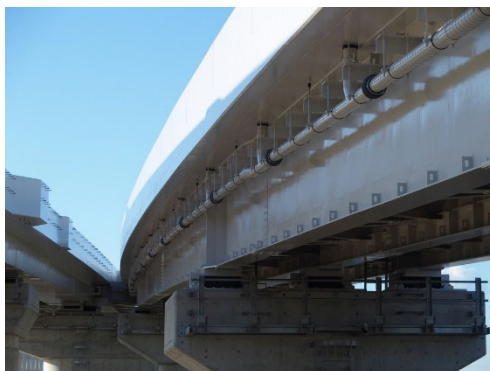
②⑥新設橋 鋼橋 白色系統の塗装を施しています
