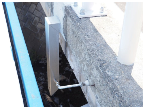
⑤設置例 フレキシブルチューブ接続
