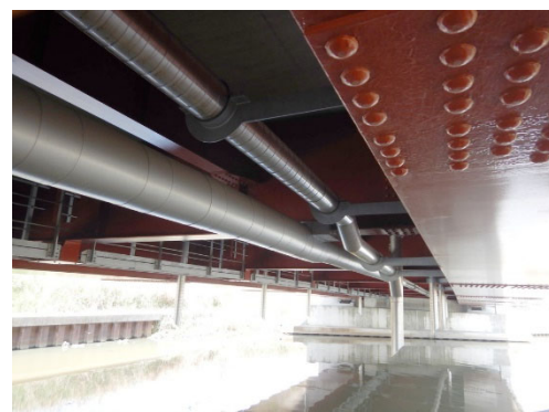
③⑩新設橋 鋼橋 桁内にTS-PIPE φ200を使用しています
