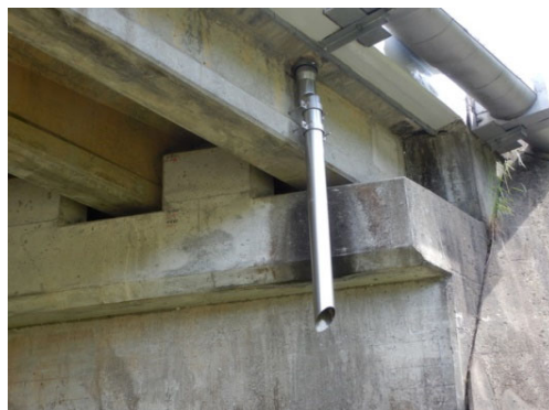
⑦設置例（全ネジボルト使用）
