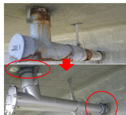
⑱設置例（RDジョイント・伸縮管使用）
