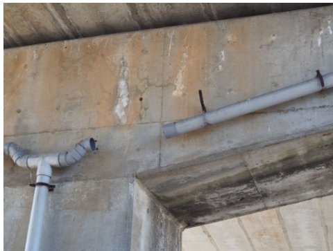
寒さ、凍結、融雪剤による劣化、損傷
