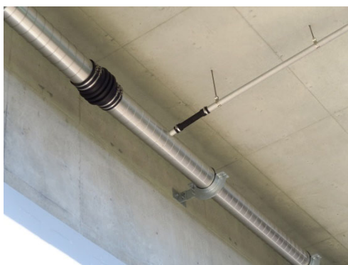
②⑨新設橋 PC橋 TS-PIPE φ200を使用しています。導水管との接続には伸縮ゴムを使用しています
