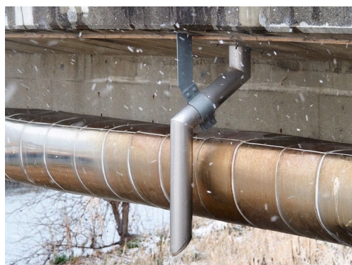
⑯設置例 曲管仕様（吊り下げ金具使用）
