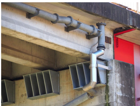
⑭設置例（伸縮管+フランジ接続例）
