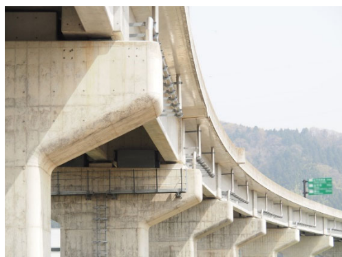
②⑧新設橋 PC橋 TS-PIPE φ200を使用しています
