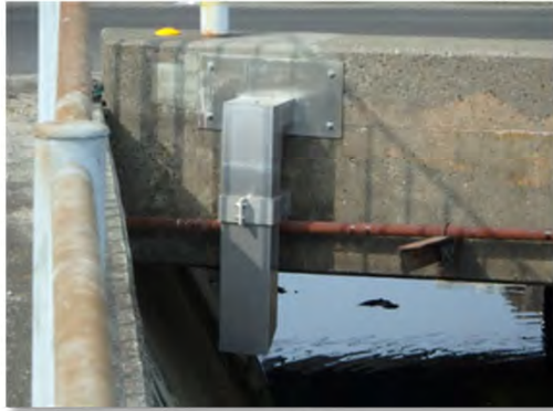
⑬補修工事 地覆貫通管設置 型枠一体の地覆貫通管設置例です
