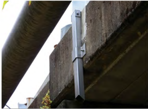
⑯補修工事 地覆貫通管設置 比較的小型の仕様です。コの字型の蓋を長めのボルト一本で取付けたシンプルな蓋付です
