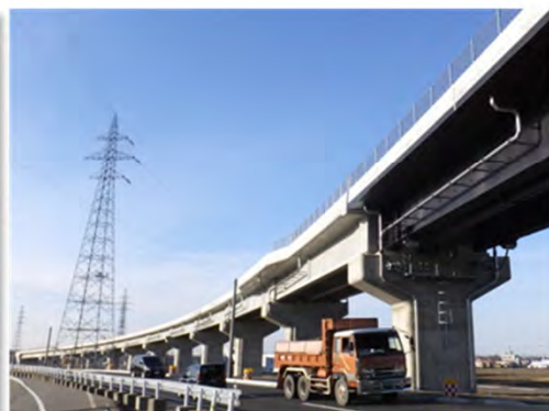
③新設橋 鋼橋-コンクリート橋
