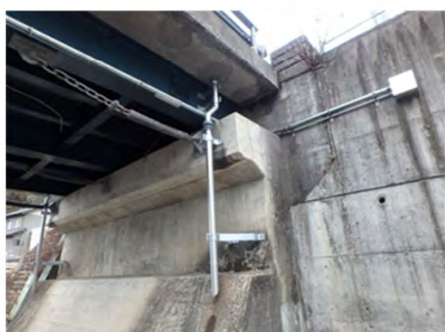
⑩補修工事 コンクリート橋
