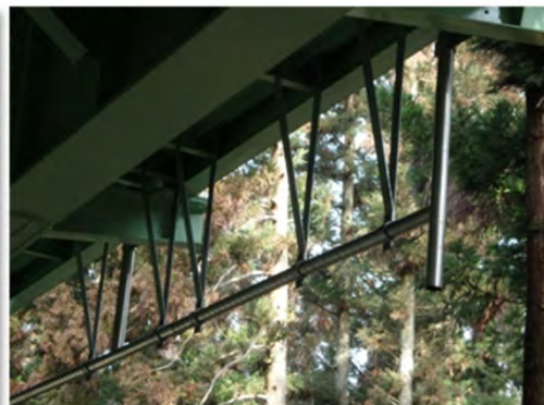
⑨補修工事 鋼橋
