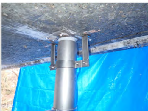
㉓補修工事 オリジナルの薄型リブ・フランジ加工のステンレス金具を吊り下げ金具として使用しています
