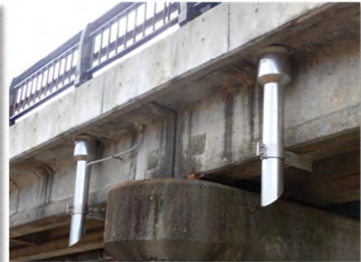
㉑補修工事 コンクリート橋 異形の天板プレート一体型排水管です
