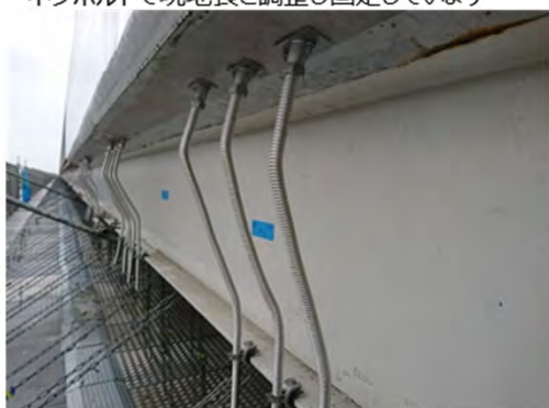
㉒補修工事 TSあとからフレキを使用しています
