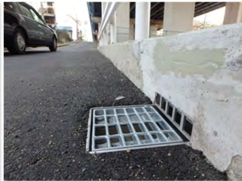
⑭補修工事 地覆貫通管設置 左記⑬写真と同形の地覆貫通管の道路側から見た写真です（グレーチング仕様）
