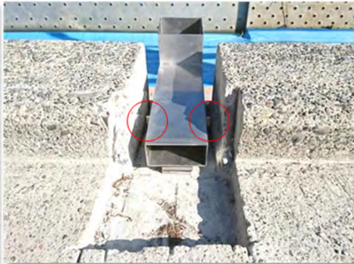
⑰補修工事 地覆貫通管 設置工事中 地覆貫通管にストッパーがついています（赤丸箇所）
