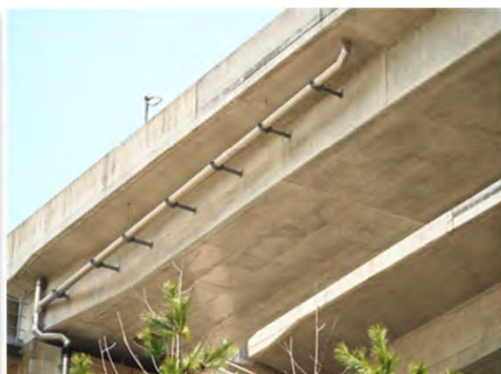
②新設橋 コンクリート橋
