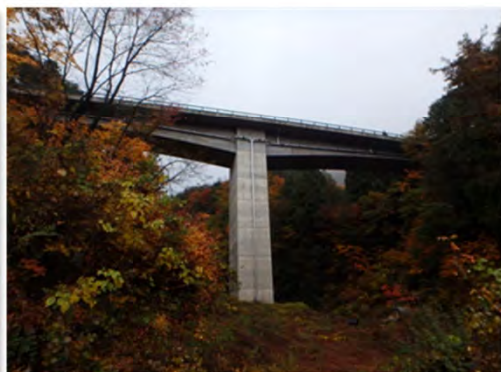
⑤新設橋 コンクリート橋
