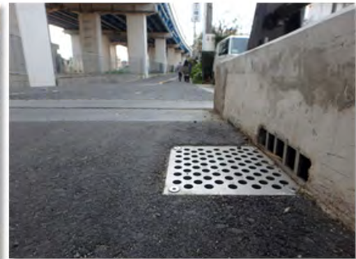
⑮補修工事 地覆貫通管設置 左記⑭写真と同工事の目皿仕様です
