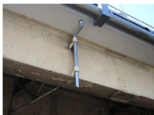
⑫補修工事 鋼橋
