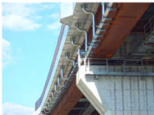
①新設橋 鋼橋
