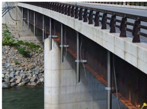
⑧新設橋 鋼橋
