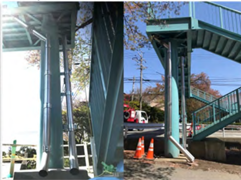
⑳補修工事 歩道橋 排水管 φ150を使用しています
