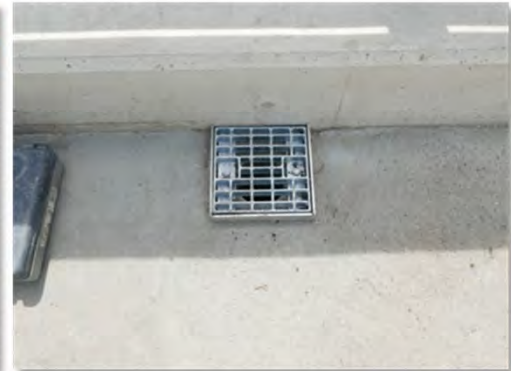
⑱補修工事 排水桝 設置工事中 舗装前の工事中の写真です
