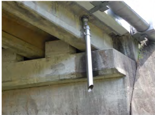
⑲補修工事 コンクリート橋 φ125を使用しています。支持はステンレスの全ネジボルトで現地長さ調整し固定しています
