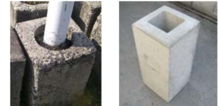
石・コンクリート 基礎
