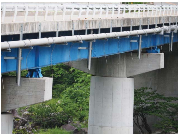
・補修工事 φ200を使用しています
