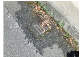
柵に土砂が堆積し詰まっている例
