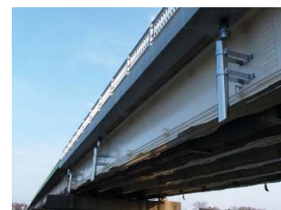
宮城県 大河原土木事務所 平成27年度 大河原大橋耐震補強・拡幅工事
