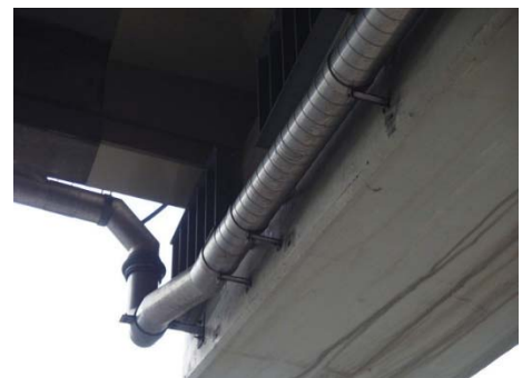
橋梁上、一般道とも交通量の多い高架橋です
