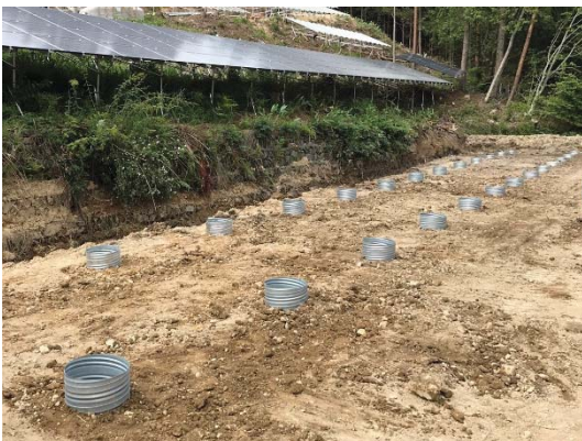
■ 鋼製スパイラル鋼管（太陽光発電の基礎に使用例）
