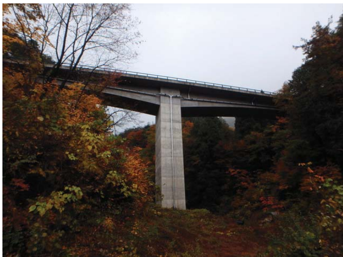
・新設橋 PC橋
