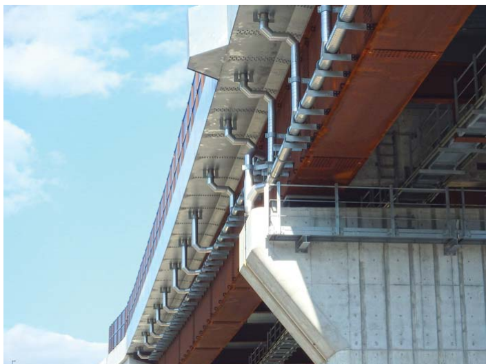
・新設橋 鋼橋
