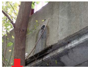
TS-PL_PIPE-L (プレートt=2mm全周曲げ仕様) 導水管 (50A) タイプ
