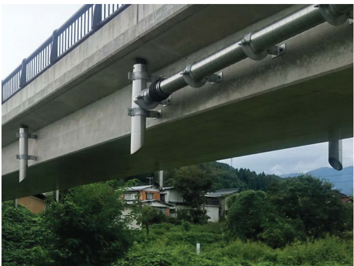
・新設橋 PC橋
