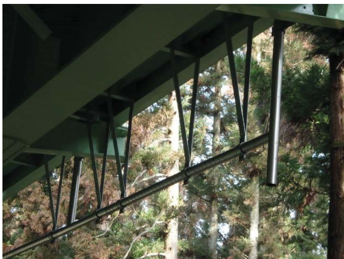
・補修工事 φ100を使用しています
