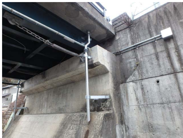
・補修工事 φ100を使用しています
