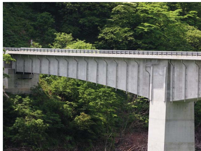
・新設橋 PC橋
