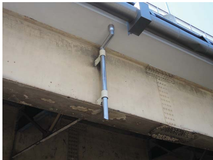
・補修工事 φ100を使用しています
