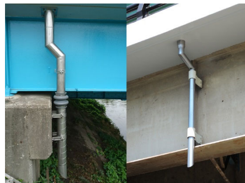
左:天板PL+スパイラル直管 右:加工管
