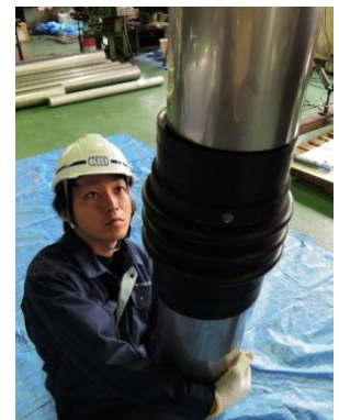
取付した下流側の管を持ち上げる 形で上流側の管へ差し込みます
