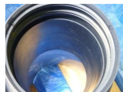
上流側からスカート部分と伸縮管 本体の間に排水管が正しく差込ま れているか確認
