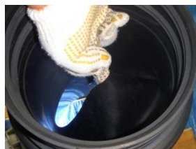
上流側からスカート部分を確認
