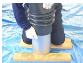
伸縮管を左右に振ったりしながら少し ずつ差込みます
