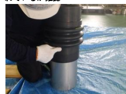
差込しろの奥まで排水管が差込まれ ているか確認（写真では指で押さえ 確認）
